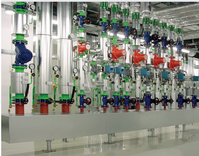
Рис. 16. Компактный монтаж с синусоидальным компактным коллектором
